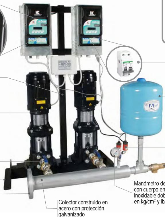
Interruptores termomagnéticos para la desconexión de cada variador
